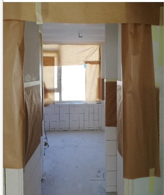
Werkzaamheden in de ontmoetingsruimte
